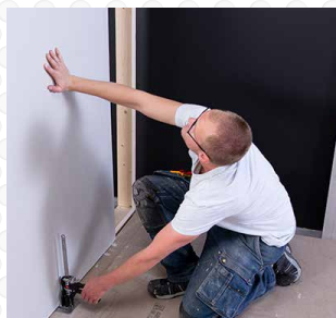
Installa cartongesso, pannelli e pareti in vetro e pietra.
