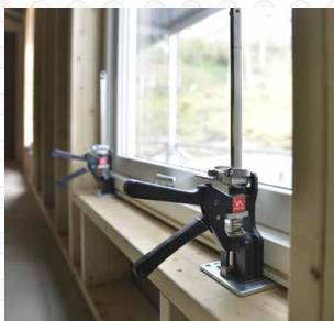
Installa finestre, telai e supporti strutturali.
