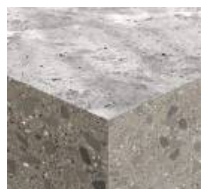
Calcestruzzo non fessurato
