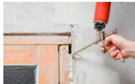
Posizionamento rapido di controltelai.
