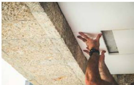
Installazione di pannelli, fregi decorativi, soglie e davanzali.
